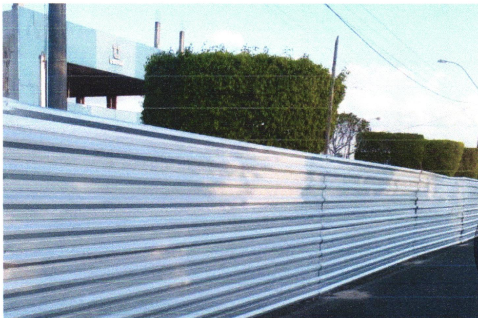
Foto 02 – TAPUME COM TELHA METÁLICA. AF_05/2018
