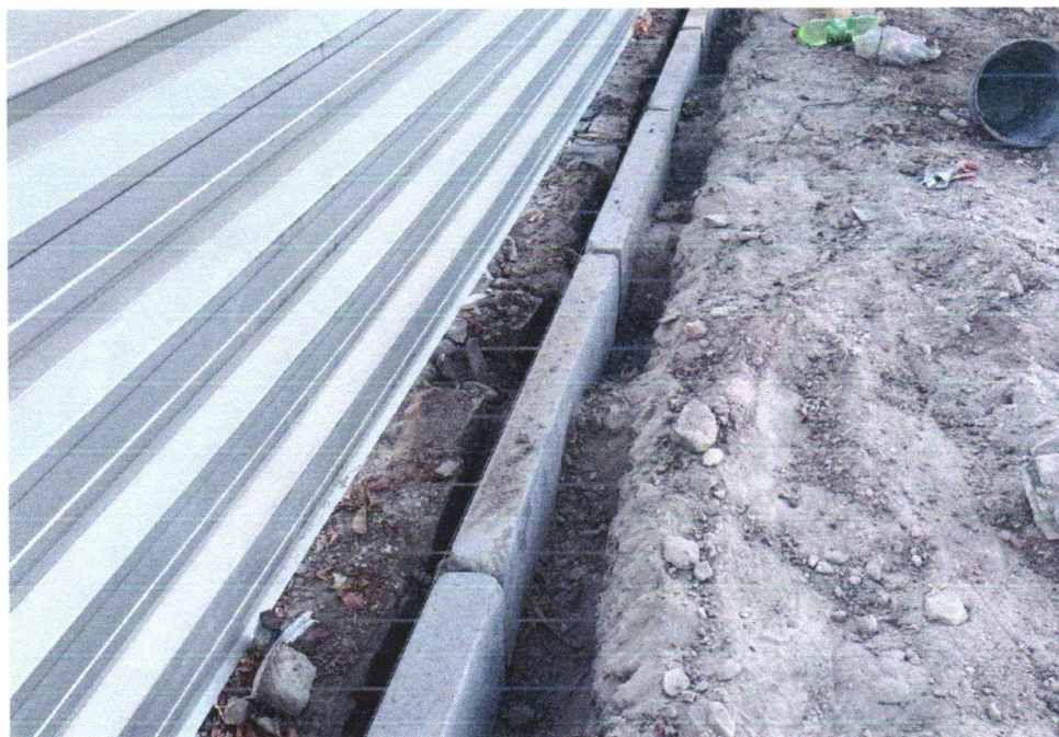
Foto 09- ASSENTAMENTO DE GUIA (MEIO-FIO) EM TRECHO RETO, CONFECCIONADA EM CONCRETO PRÉ-FABRICADO, DIMENSÕES 100X15X13X20 CM (COMPRIMENTO X BASE INFERIOR X BASE SUPERIOR X ALTURA), PARA URBANIZAÇÃO INTERNA DE EMPREENDIMENTOS. AF_06/2016_P
