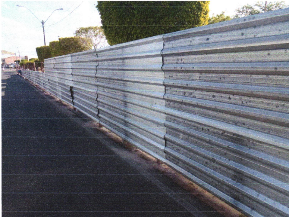
Foto 01 - TAPUME COM TELHA METÁLICA. AF_05/2018
