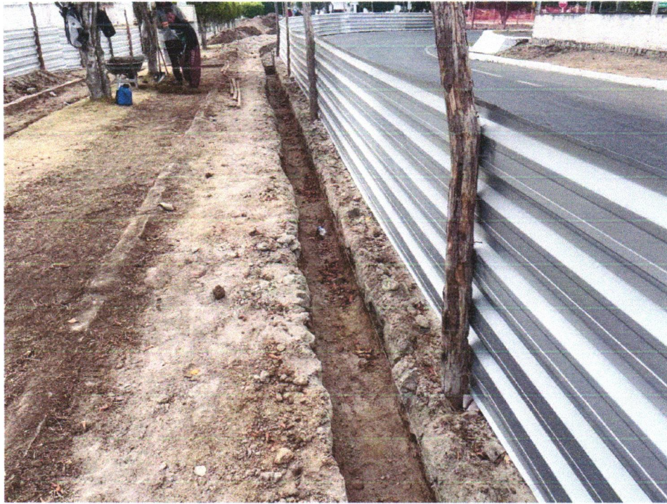
Foto 05 - ESCAVAÇÃO MANUAL DE VALA COM PROFUNDIDADE MENOR OU IGUAL A 1,30 M
