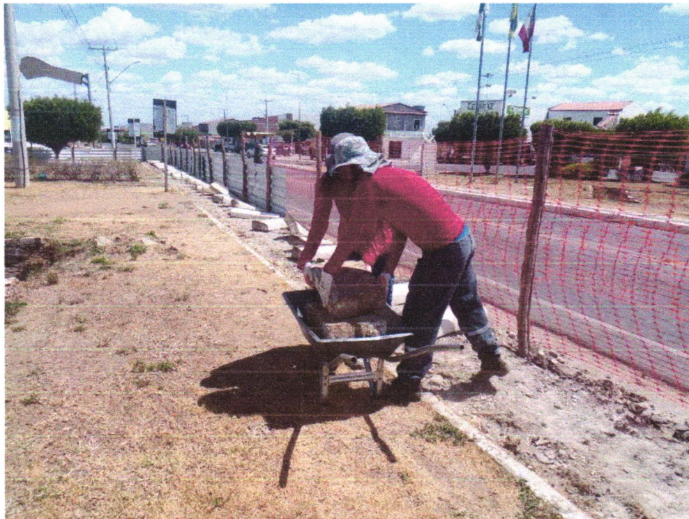
Foto 03- RETIRADA DE MEIO-FIO DNER / ECONOMICO COM EMPILHAMENTO E SEM BOTA FORA
