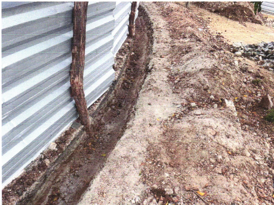
Foto 06 - ESCAVAÇÃO MANUAL DE VALA COM PROFUNDIDADE MENOR OU IGUAL A 1,30 M
