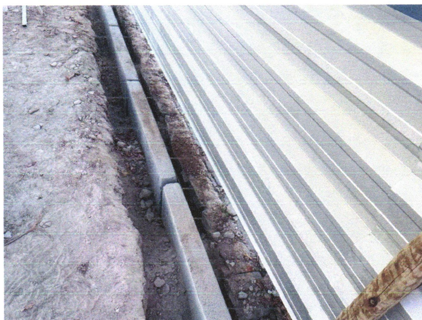
Foto 10 - ASSENTAMENTO DE GUIA (MEIO-FIO) EM TRECHO RETO, CONFECCIONADA EM CONCRETO PRÉ-FABRICADO, DIMENSÕES 100X15X13X20 CM (COMPRIMENTO X BASE INFERIOR X BASE SUPERIOR X ALTURA), PARA URBANIZAÇÃO INTERNA DE EMPREENDIMENTOS. AF_06/2016_P
